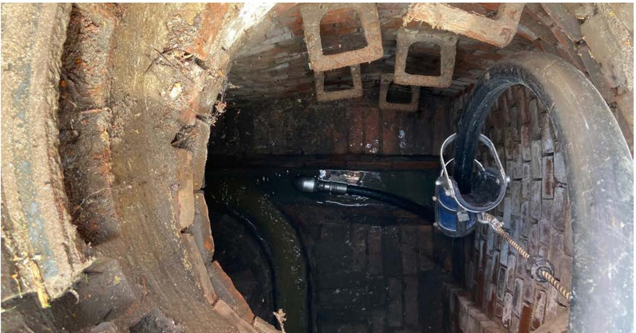
Abbildung 6: Reinigungsdüse Kanal (Quelle: Hamburger Stadtentwässerung AÖR)
