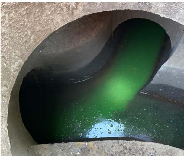
Abbildung 5: Farbwasserprobe im Kanal
