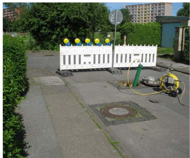
Abbildung 8: Einsatz eines Kanalfernauges (KFA) (Quelle: Hamburger Stadtentwässerung AÖR)
