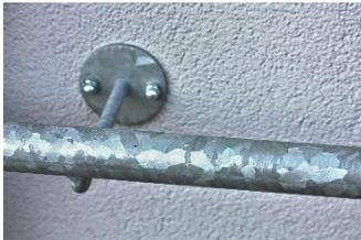
verzinkter Stahl: grau, metallischer Glanz, **Struktur**
