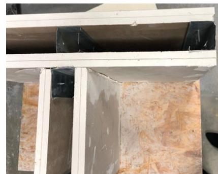
Abb.1: Abbildungen der fertig montierten Wand-T-Verbindung.
