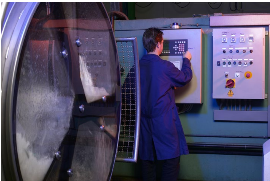
Abbildung 6: Prozesssteuerung am Gerbautomaten
