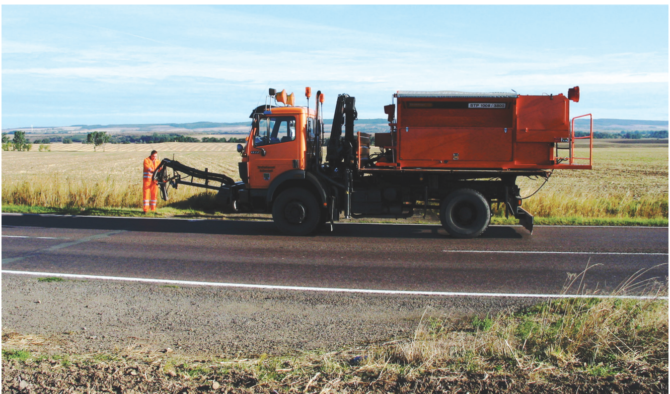
Beseitigung von Schäden an Fahrbahnen mit dem „Road-Repair-Patcher“
