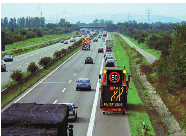
Wartung und Instandhaltung der Straßenausstattung
