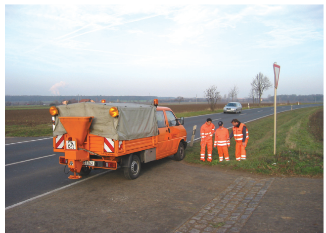
Streckenwartung und -überwachung
