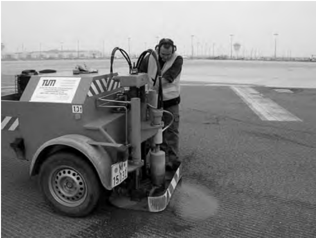
Entnahme von Bohrkernen auf einem Flughafengelände
