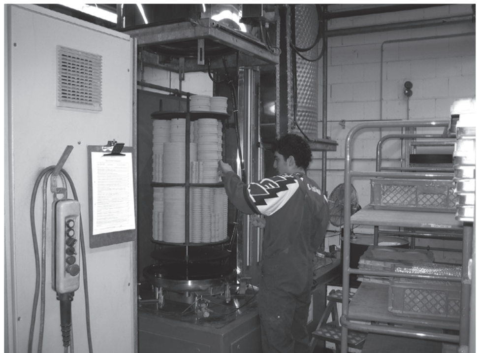
Vorbereitung einer Entbinderungsanlage
