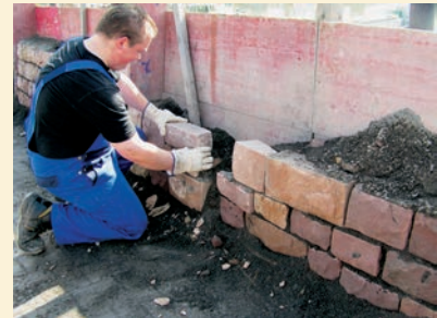
Sanieren einer Ufermauer
