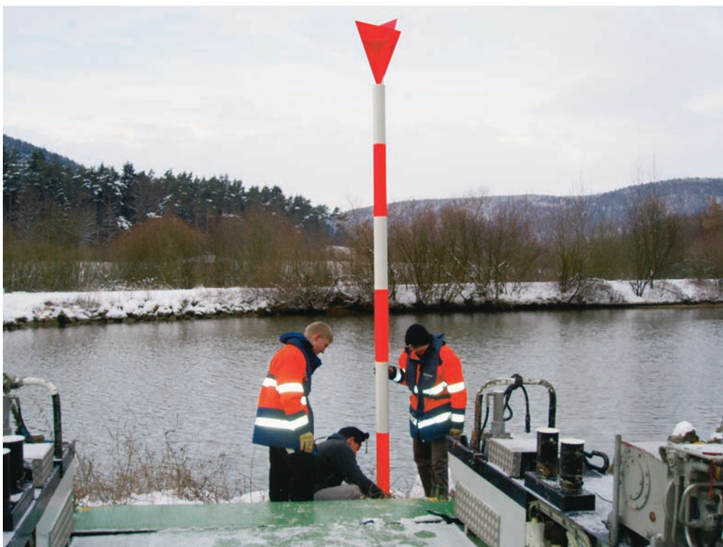
Setzen einer Bake
