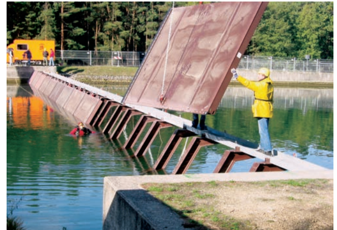
Setzen eines Revisionsverschlusses
