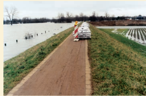
Sichern eines Hochwasserschutzdeiches mit Sandsäcken
