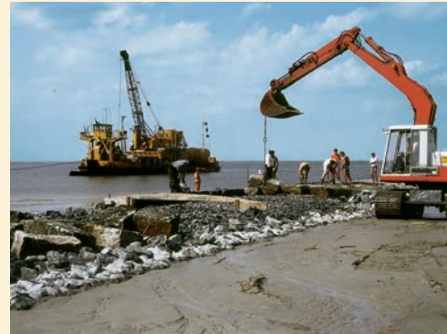
Buhnen und Regelungsbauwerke
