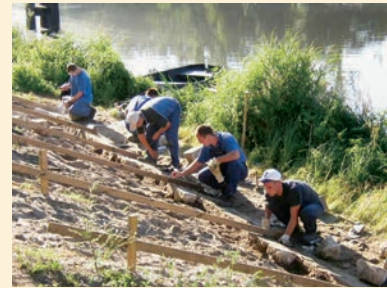
Herstellen einer Sicherung am Schrägufer
