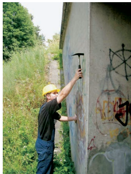
Bauwerksinspektion an einem Durchlass
