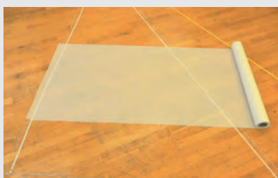
Abb. 34: Auslegen der ersten Tuchbahn
