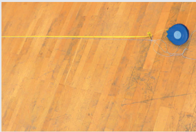
Abb. 23: Vorliekslänge anzeichnen
