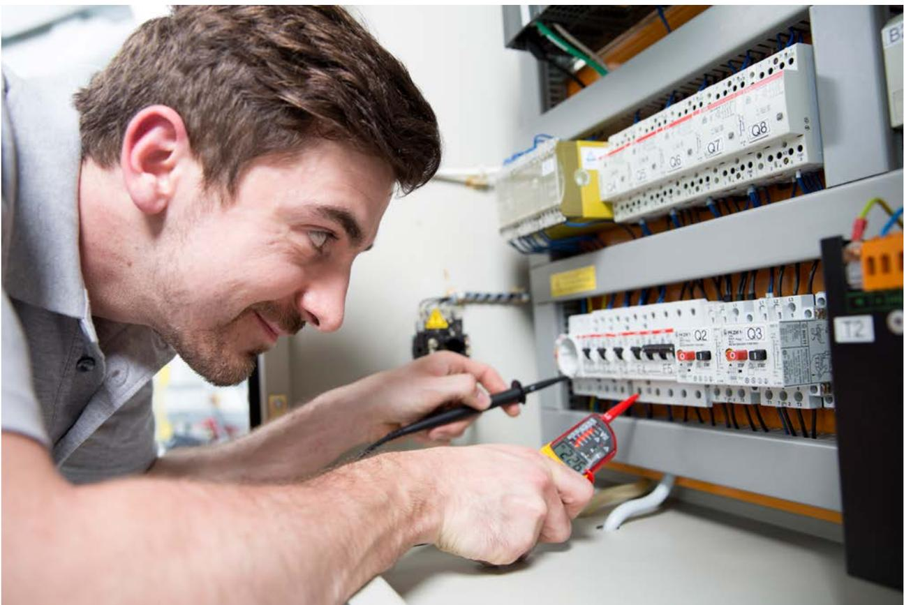
Abbildung 9: Messungen am Schaltschrank (Quelle: ZVEH)
