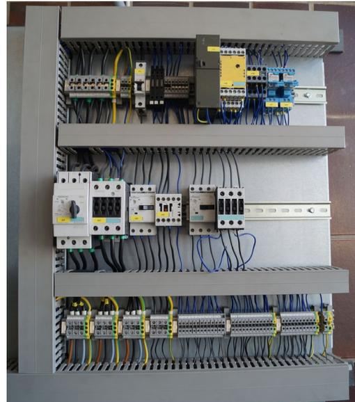
Abbildung 14: Schaltgerätekombination für Prüfung von Servomotoren (Quelle: Klebs+Hartmann GmbH & Co. KG)
