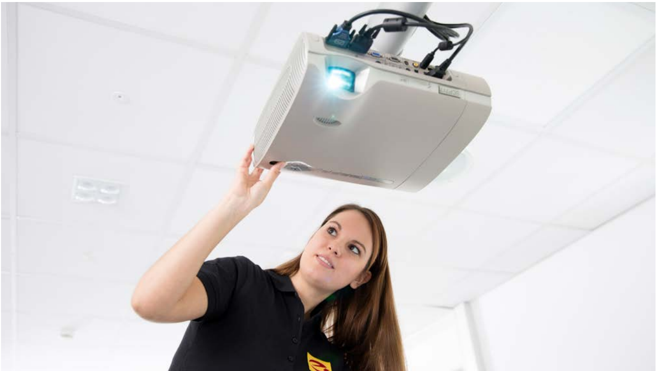
Abbildung 7: Montage eines Beamers (Quelle: ZVEH)
