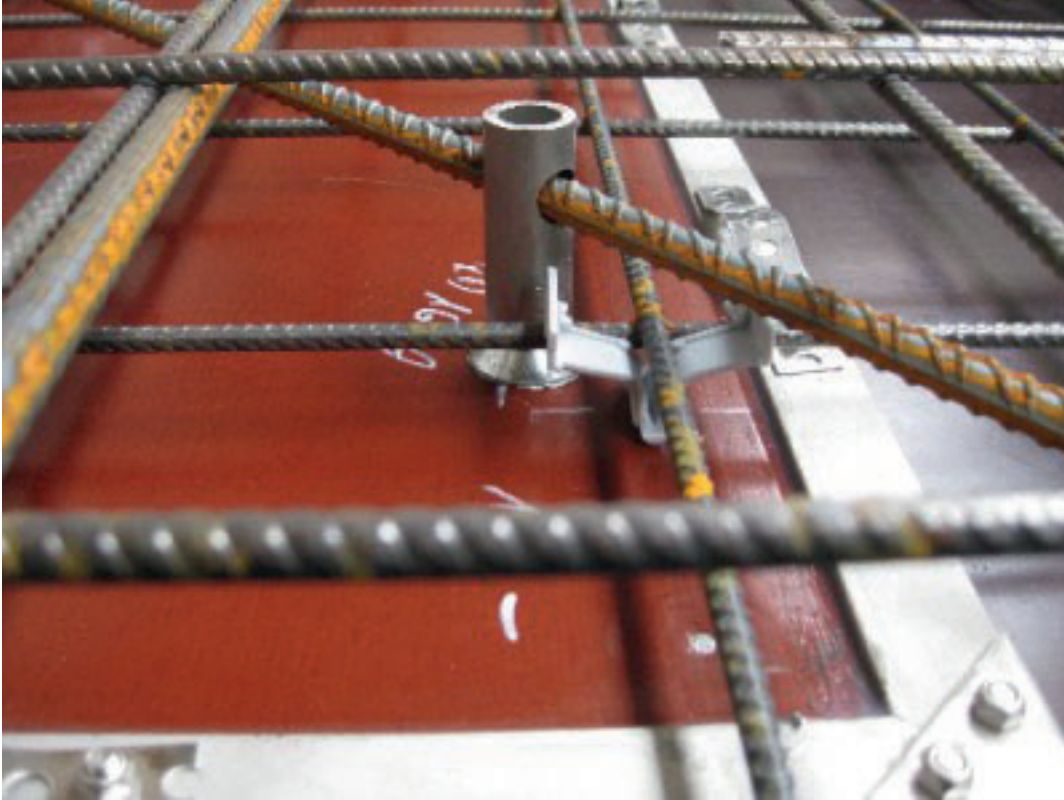
Abbildung 3: Einbau von Abstandshaltern aus Kunststoff © Krauskopf
