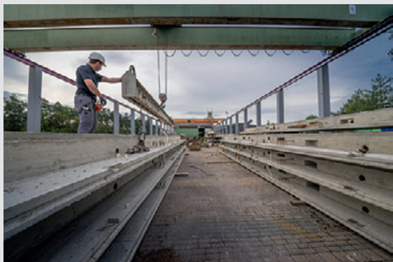
Abbildung 4: Verwendung von Traversen zum Heben von Fertigteilen © Fuchs Fertigteilwerke
