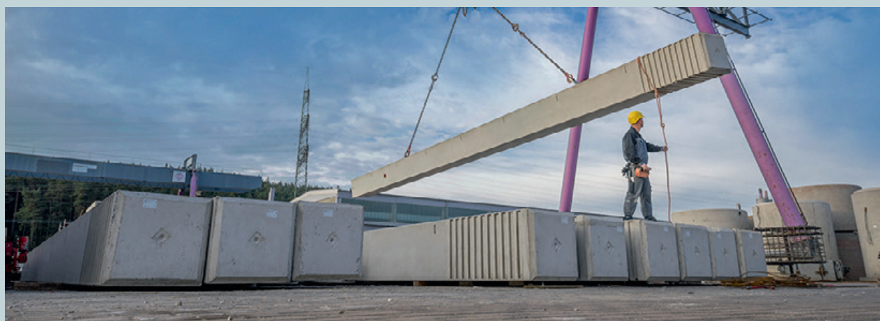
Abbildung 5: Sicheres Anschlagen von Hebezeugen an Fertigteilen © Fuchs Fertigteilwerke
