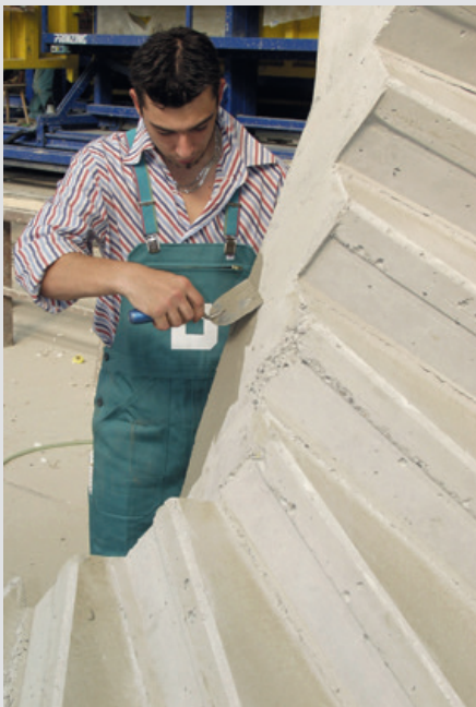
Abbildung 16: Ausbessern von Betonfertigteilen © BBF
