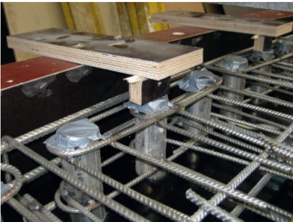
Abbildung 14: Zusätzliche Sicherung der Bewehrungsposition © Krauskopf
