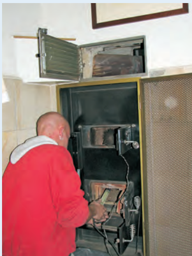
Reinigung von Kachelöfen und Warmluft-Heizung
