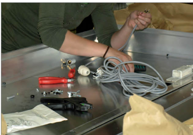
Typische Prüfungssituation: Installation der Leuchtmittel in eine Lichtwerbeanlage © Markus Beusch
