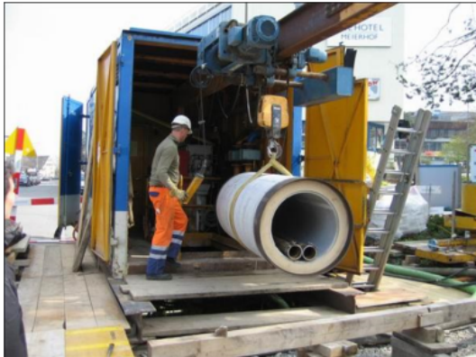
Abb.: Paust-Lassen: Einbau von Abwasserrohrelementen zur Sanierung von Bruchschäden
