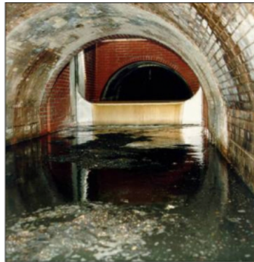
Abb.: Berliner Wasserbetriebe für Studie „Ökologisches Bauen“ 2010: „Regenüberlaufwehr“
