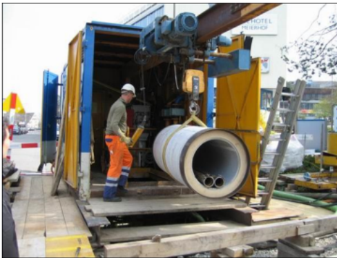
Einbau von Abwasserrohrelementen zur Sanierung von Bruchschäden
