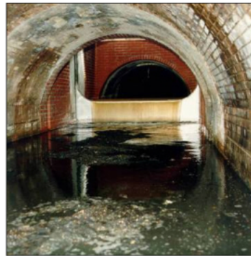
Berliner Wasserbetriebe für Studie „Ökologisches Bauen“ 2010: „Regenüberlaufwehr“
