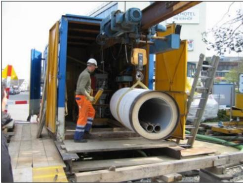
Einbau von Abwasserrohrelementen zur Sanierung von Bruchschäden
