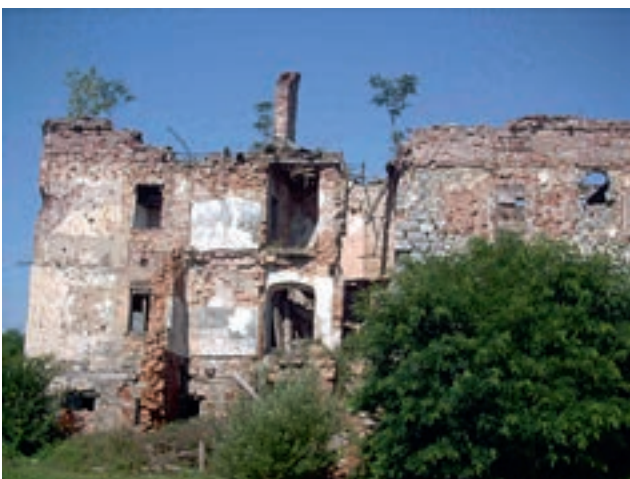
Im kroatischen Unabhängigkeitskrieg zerstörte Häuser (in Turanj nahe Karlovac)
