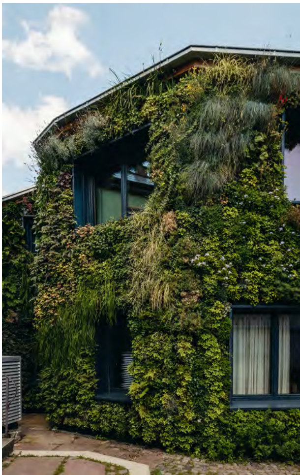
Abb. 25: Um das Gewicht niedrig zu halten, wachsen die Pflanzen nicht in Substrat, sondern in einer anorganischen Mineralwolle. Quelle: Helix Pflanzensysteme/Raissa Axmann Fotografie
