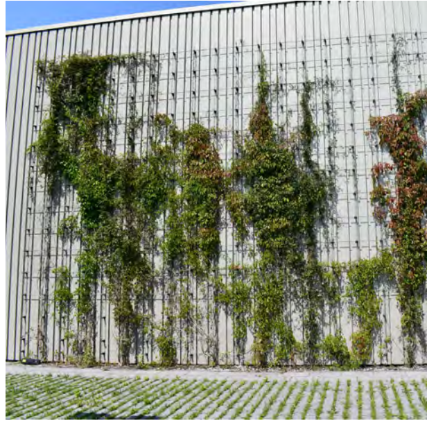
Abb. 60: Bodengebundene Fassadenbegrünungen mit Netzen bzw. Gittern lassen sich theoretisch gut erfassen ... Quelle: BuGG
