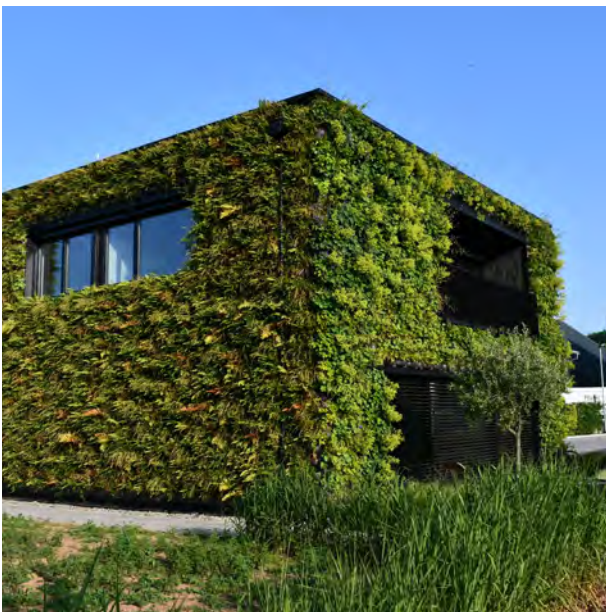
Abb. 59: ... ebenso wie wandgebundene Fassadenbegrünungen. Hier lassen sich die Flächen in Quadratmeter gut ermitteln. Quelle: BuGG
