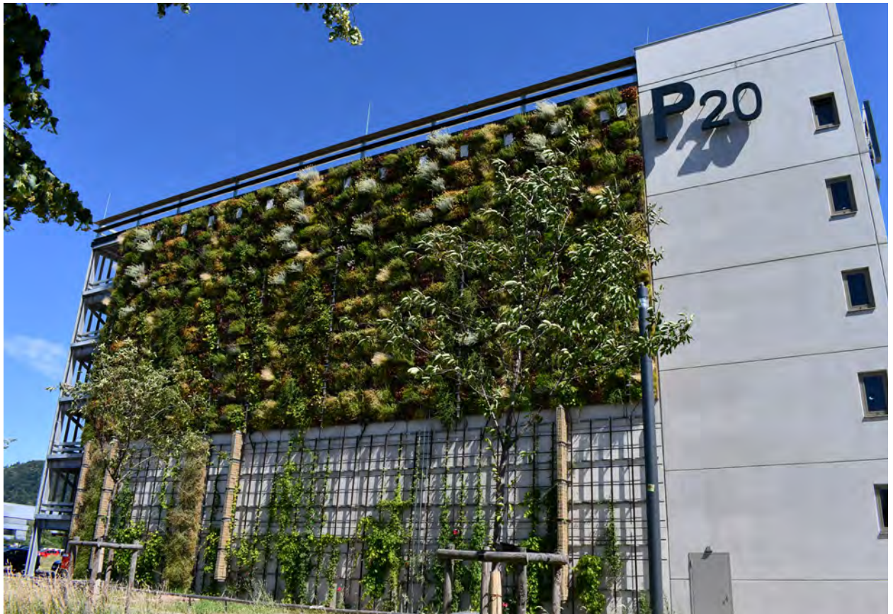
Abb. 57: In Deutschland wurden in 2024 etwa 109.600 m 2 bodengebundene Fassadenbegrünungen mit Kletterhilfen (unten im Bild) und etwa 27.500 m 2 wandgebundene Fassadenbegrünungen (oben im Bild) umgesetzt. Quelle: BuGG
