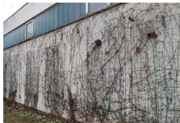
Abb. 28: Die Kontrolle der Kletterhilfe und der Fassade erfolgt vorzugsweise im Winter. Quelle: BuGG
