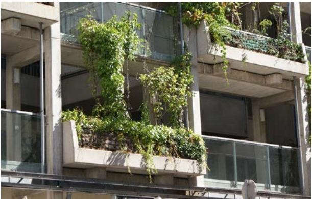
Abb. 39: Die Fassade muss mind. einmal jährlich auf Schäden kontrolliert werden. Quelle: BuGG
