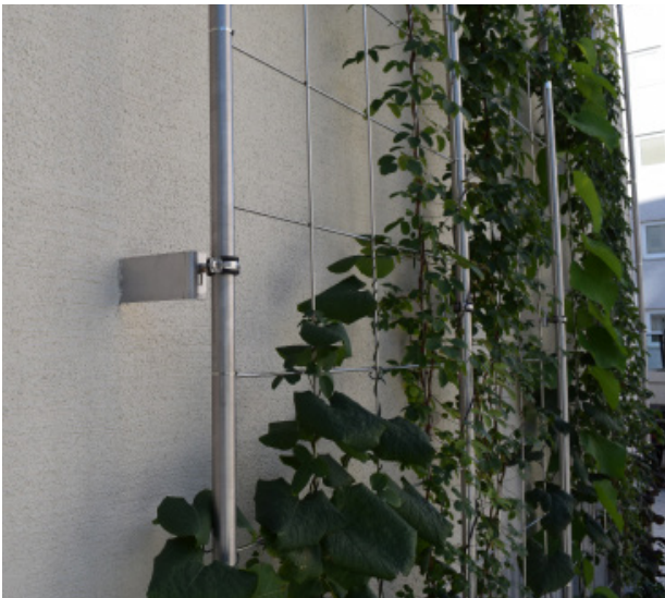
Abb. 23: Kombination verschiedener Gerüstkletterpflanzen an einer Gitterstruktur. Quelle: BuGG
