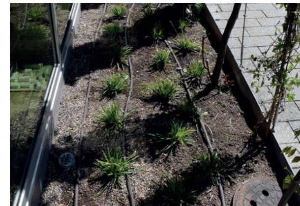
Abb. 16: Bewässerung über Tropfschläuche bei Regenschatten. Quelle: BuGG
