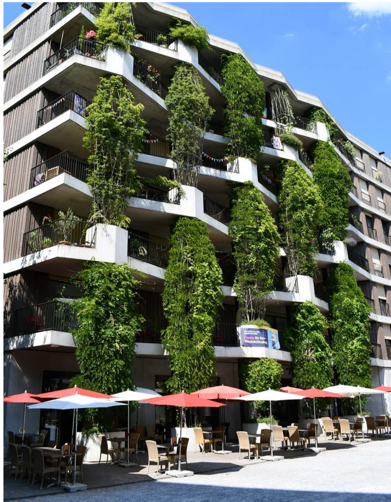
Abb. 1: Wandgebundene Fassadenbegrünung in Pflanztrögen mit Gerüstkletterpflanzen. Quelle: BuGG
