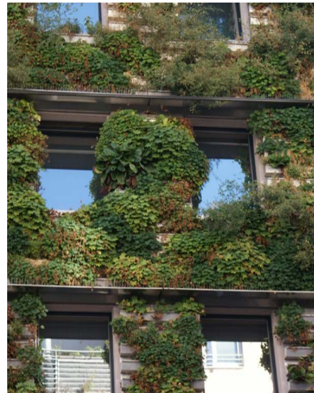
Abb. 11: Horizontale Regalbauweise mit Stauden. Quelle BuGG
