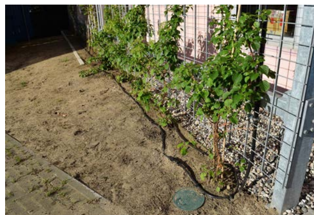
Abb. 29: Bewässerungsanlagen müssen regelmäßig gewartet werden. Quelle: BuGG
