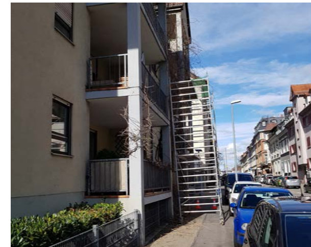
Abb. 41: Fahrbares Gerüst bei der Pflege der Gerüstkletterpflanzen. Quelle: BuGG
