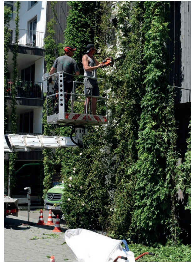
Abb. 46: Sperrung des Arbeitsbereiches bei der Pflege einer bodengebundenen Fassadenbegrünung mit Gerüstklettopflanzen. Quelle: BuGG
