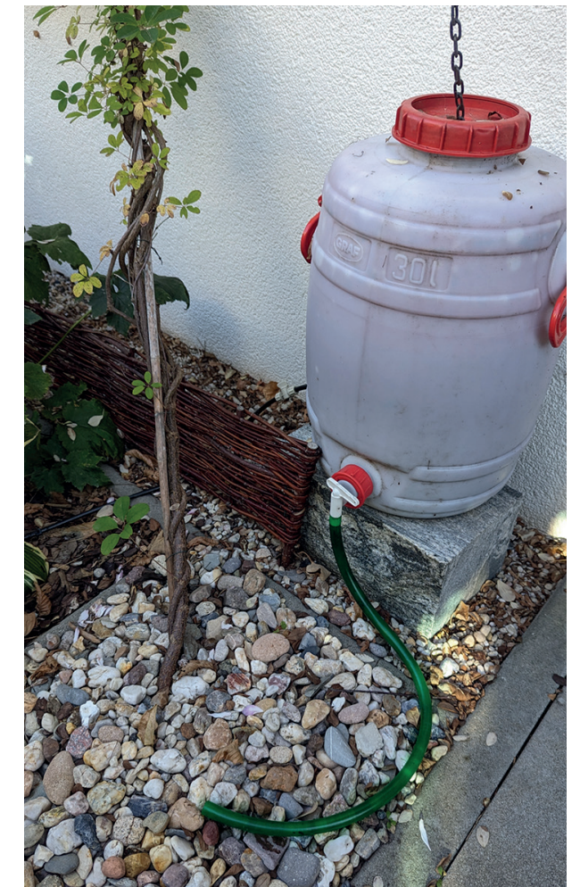
Abb. 18: Notfallbewässerung im privaten Bereich mit Regenwasser. Quelle: BuGG
