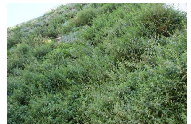
Abb. 31: Bei dieser wandgebundenen Begrünung haben die Brennnesseln überhand genommen. Quelle: BuGG
