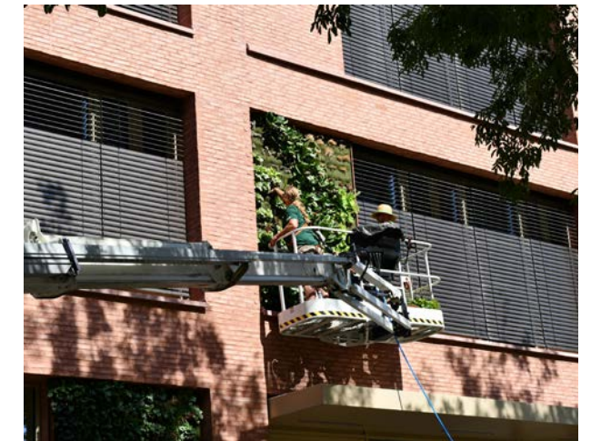
Abb. 42: Hubarbeitsbühne bei der Pflege der wandgebundenen Fassadenbegrünung. Quelle: BuGG
