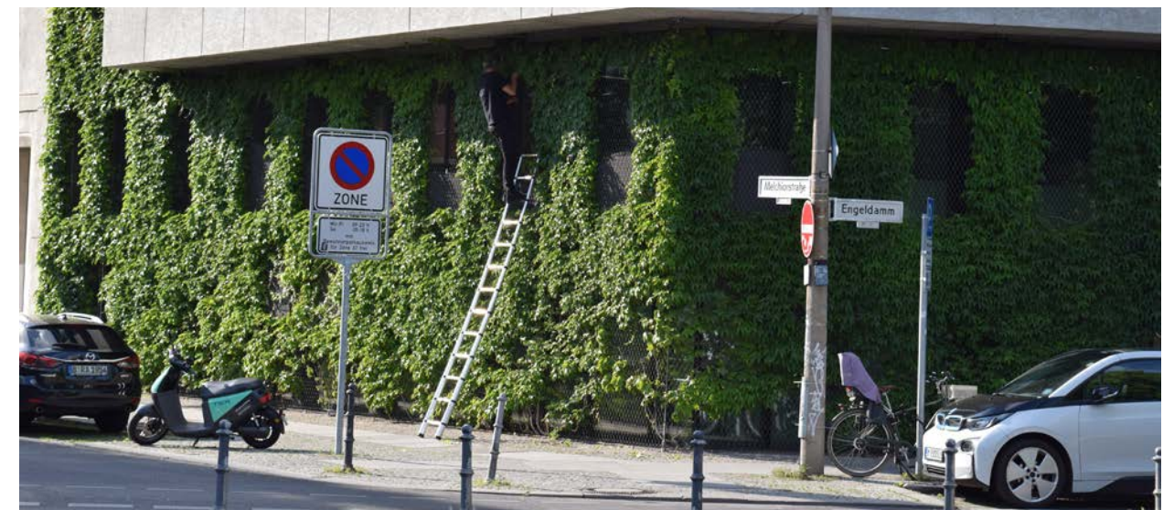
Abb. 44: Leitern sind nur für einfache, kurzfristige Pflege- und Wartungsarbeiten zulässig. Quelle: BuGG
