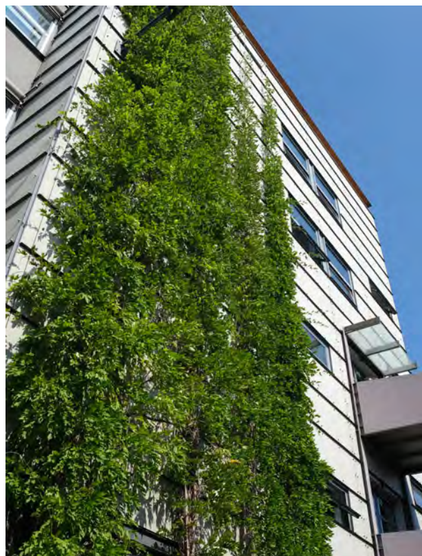
Abb. 190: Gerüstkletterpflanze (Blauregen, Wisteria ) an vorgehängt hinterlüfteter Fassade. Quelle: BuGG
