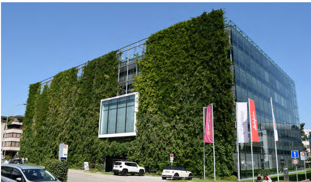
Abb. 186: Verschiedene Gerüstkletterpflanzen an vorgestellter, selbsttragender Stahlkonstruktion vor einer Pfosten-Riegel-Fassade. Quelle: BuGG
