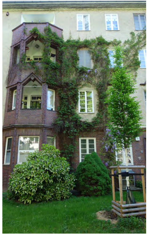
Abb. 49: Pflanzfläche im privaten Grundstück. Quelle: BuGG
