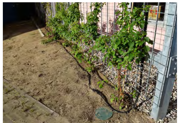
Abb. 58: Kontrolle der Bewässerungsanlage. Quelle: BuGG
