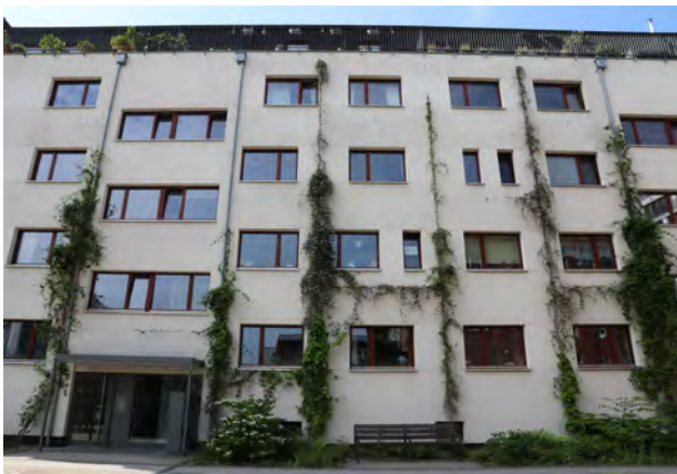
Abb. 67: Schnittmaßnahmen sind erforderlich u.a. beim Freihalten von technischen Einrichtungen, wie Fallrohren oder Blitzschutzanlagen, und beim Überwuchs auf Fenster oder Dächern. Quelle: BuGG
