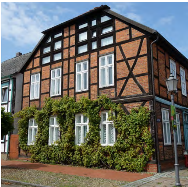
Abb. 193: Gerüstkletterpflanze an Fachwerk mit guter Erreichbarkeit für die Pflege und Wartung. Quelle: BuGG
