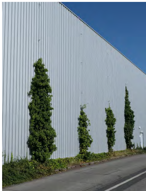
Abb. 184: Gerüstkletterpflanze an Metallfassade. Quelle: BuGG
