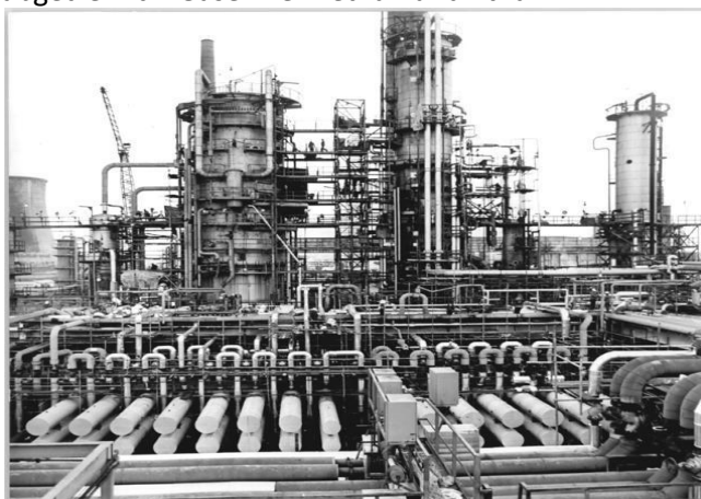
Abb. 97c: Eine Anlage zur Erdöldestillation (Hier: die Rohöldestillationsanlage II im PCK Schwedt) (Bildquelle: Von Bundesarchiv, Bild 183-P1210-0302 / Müller / CC-BY-SA 3.0, CC BY-SA 3.0 de, https://commons.wikimedia.org/w/index.php?curid=5435982 )
