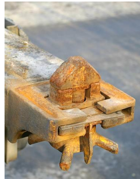
Abb.: Rostige Container-Verriegelung - Eisen korrodiert leicht, denn es reagiert chemisch mit Wasser und Luftsauerstoff zu Rost. Das ist eine chemische Stoffeigenschaft.
