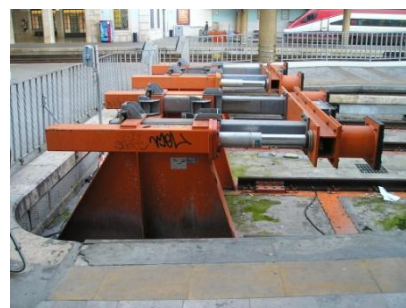
Abb. 3.19: Puffer am Ende eines Bahngleises
