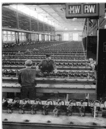
Abb. 1.41: Blick in die Elektrolysenhalle des Chlorbetriebs III mit Bitterfelder Chemiewerkern in der DDR 1958. Damals wurden zur Elektrolyse von Salzwasser noch Elektroden aus giftigem Quecksilber verwendet
