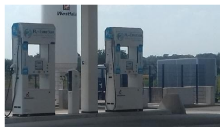
Abb. 1.4: Eine Wasserstoff-Tankstelle. Die im Wasserstoffgas und im Luftsauerstoff gespeicherte Energie wird beim Verbrennen des Energieträgers zu Wasserdampf – eine Stoffvereinigung (Eig. Foto).
