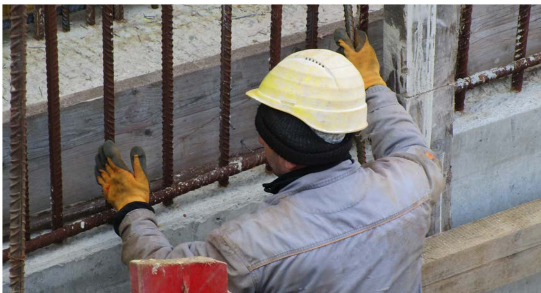
Abb. 22 Durch den Einsatz einer zu dicken Mütze kann der sichere Sitz des Kopfschutzes nicht mehr gewährleistet werden
