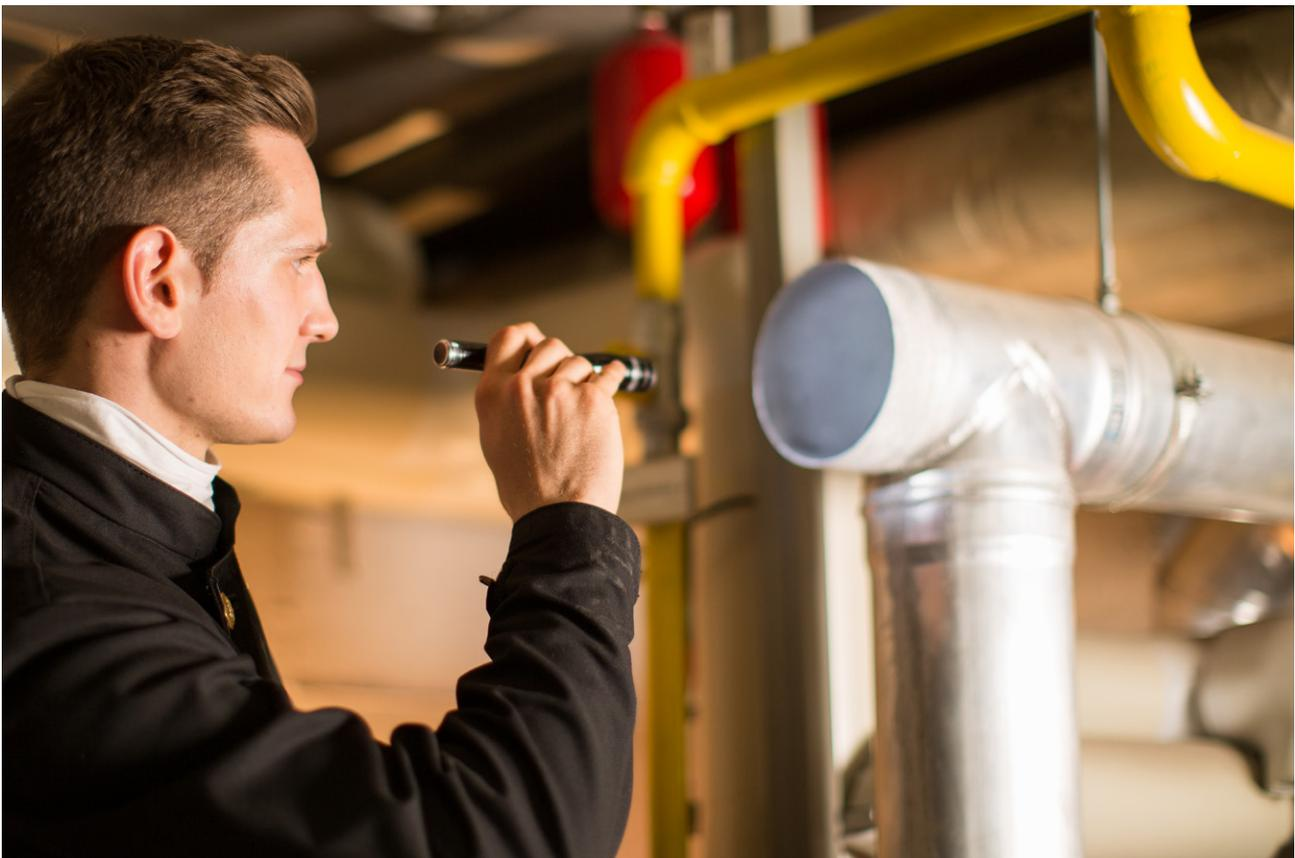
Abbildung 4: Inspektion einer Abgasleitung (Quelle: Bundesverband des Schornsteinfegerhandwerks)
