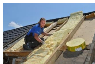
Ein Dachdecker isoliert ein Hausdach (Bild: amh)
