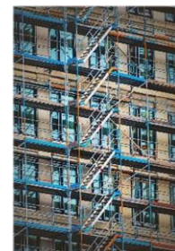
Baugerüst (© Pixabay; Didgeman)
