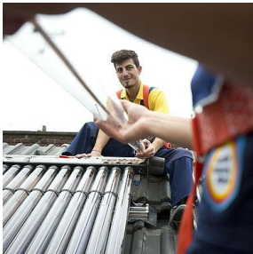
Abbildung 1: Anlagenmechaniker für Sanitär-, Heizungs- und Klimatechnik installieren eine Solaranlage (Bild: zvschk)
