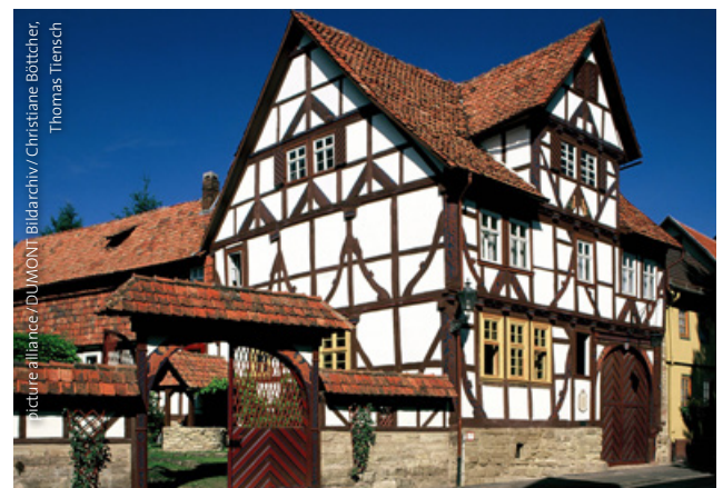
Fachwerkhaus an der Schlagdstraße im hessischen Wanfried. Im Ortskern der Kleinstadt an der Werra wurde der wertvolle Fachwerkbestand zum Teil aufwändig restauriert.
