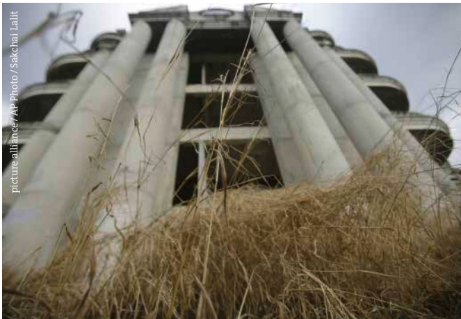
Die Asienkrise 1997 beendet den Immobilienboom in Thailand. Bauruine „Ghost Tower“ in Bangkok, einst geplant für Luxusapartements
