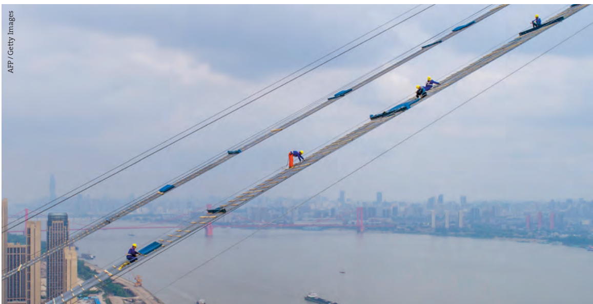
In den vergangenen Jahren hat China massiv in die Infrastruktur investiert. Arbeiter beim Bau der weltweit längsten Doppelstock-Hängebrücke über den Chang Jiang (Jangtsekiang) in Wuhan im Juni 2018
