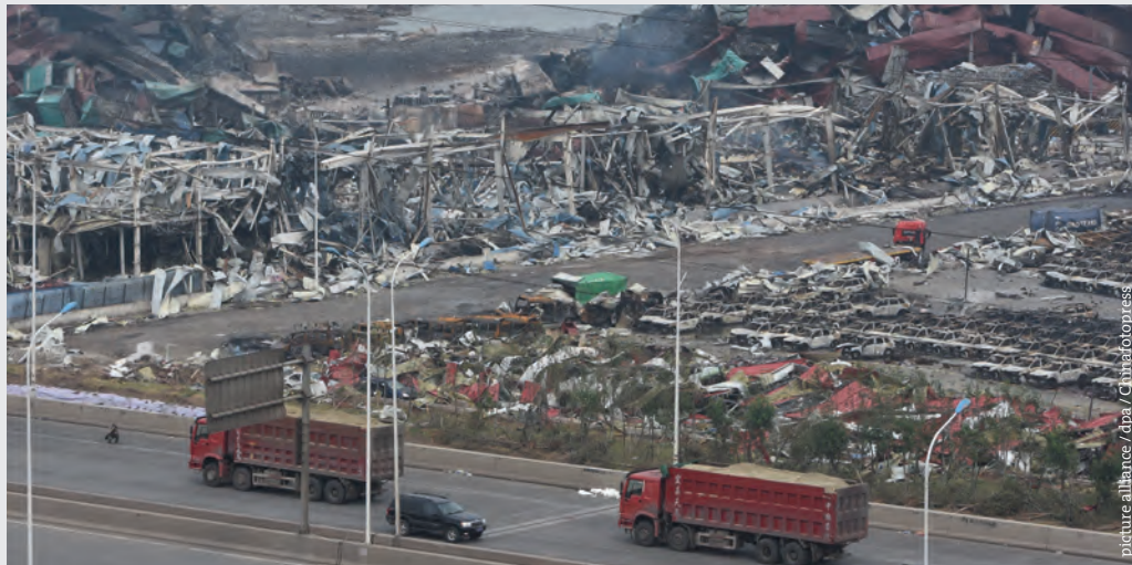
Bei der Explosion eines Chemielagers in Tianjin 2015 starben zahlreiche Menschen und zahllose Gebäude wurden zerstört.
